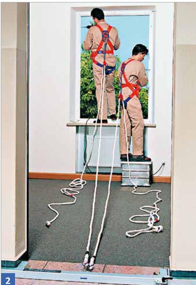
Bei Arbeiten mit Absturzgefahr geeignete Rückhaltesysteme verwenden.
